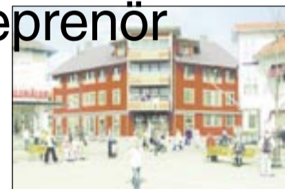
JK Bygg byggde bostäderna vid kvarteret Facklan för Aranäs.
