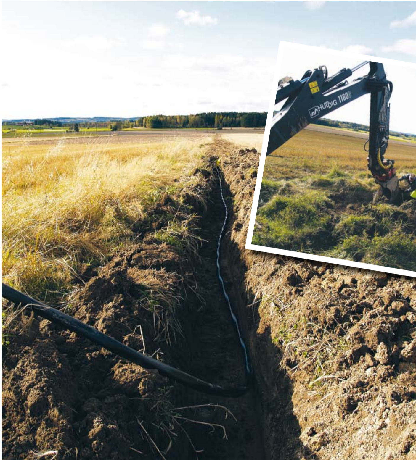
Fortum gräver ned kraftledningarna i Värmland inom programmet SäkraNät. Tryggade elleveranser innebär en tryggare vardag för Fortums totalt 865 000 kunder. Bilderna är från arbetet i Östra Ämtervik hösten 2009, entreprenör är Christer Sjögren.
