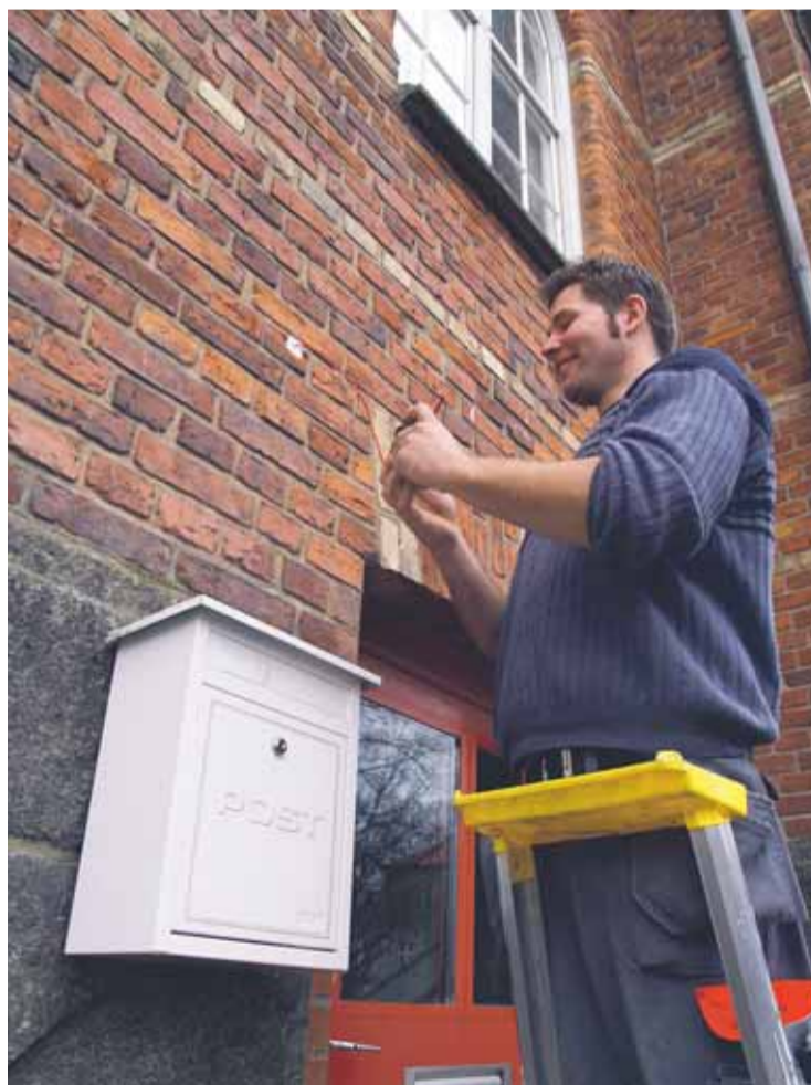
Emil Lundgren AB installerar nytt brandlarm i Norra skolan. Övre bilden: Elektriker Robert Land monterar blixtljus på fasaden till hjälp för Räddningstjänsten att finna anläggningens larmcentral. Lilla bilden: Rektor Eva Glenning i samspråk med Robert Land och affärsenhetschef Per Ekeröth.
