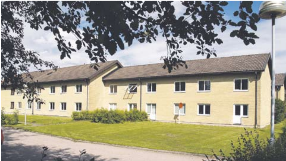
Kring årsskiftet står det klart: Vänersborgs nya Arena Hotell med 65 rum. Centralt beläget mitt emellan stadskärnan och Sportcentrum med nya Arena Vänersborg.
