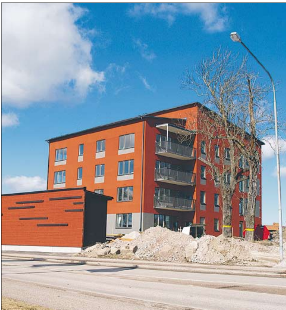
I juni står det av NCC nybyggda bostadshuset i centrala Hallstahammar klart för inflyttning. HFAB sköter uthyrning och förvaltning.
