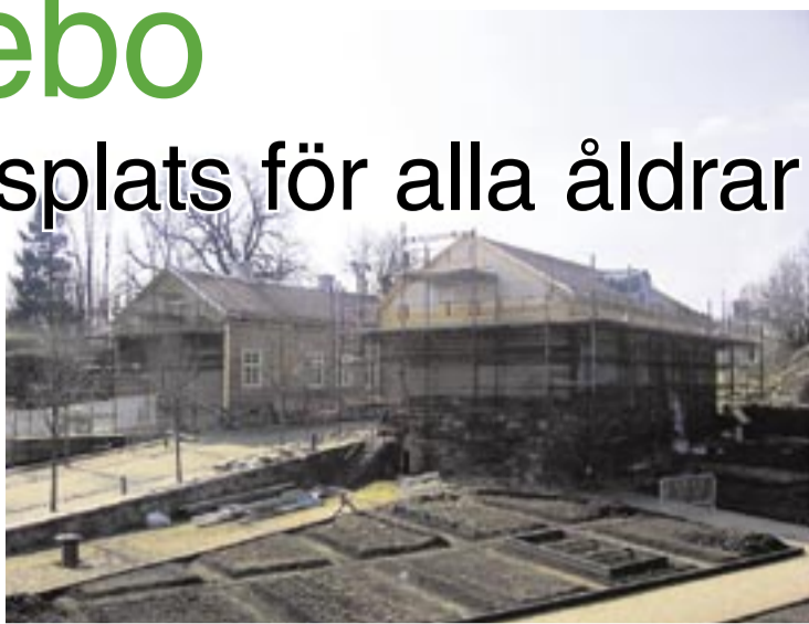
Gunnebos två fristående flygelbyggnader står färdiga sommaren 2005. I april var båda under tak. Foto: Stefan Karlberg.
