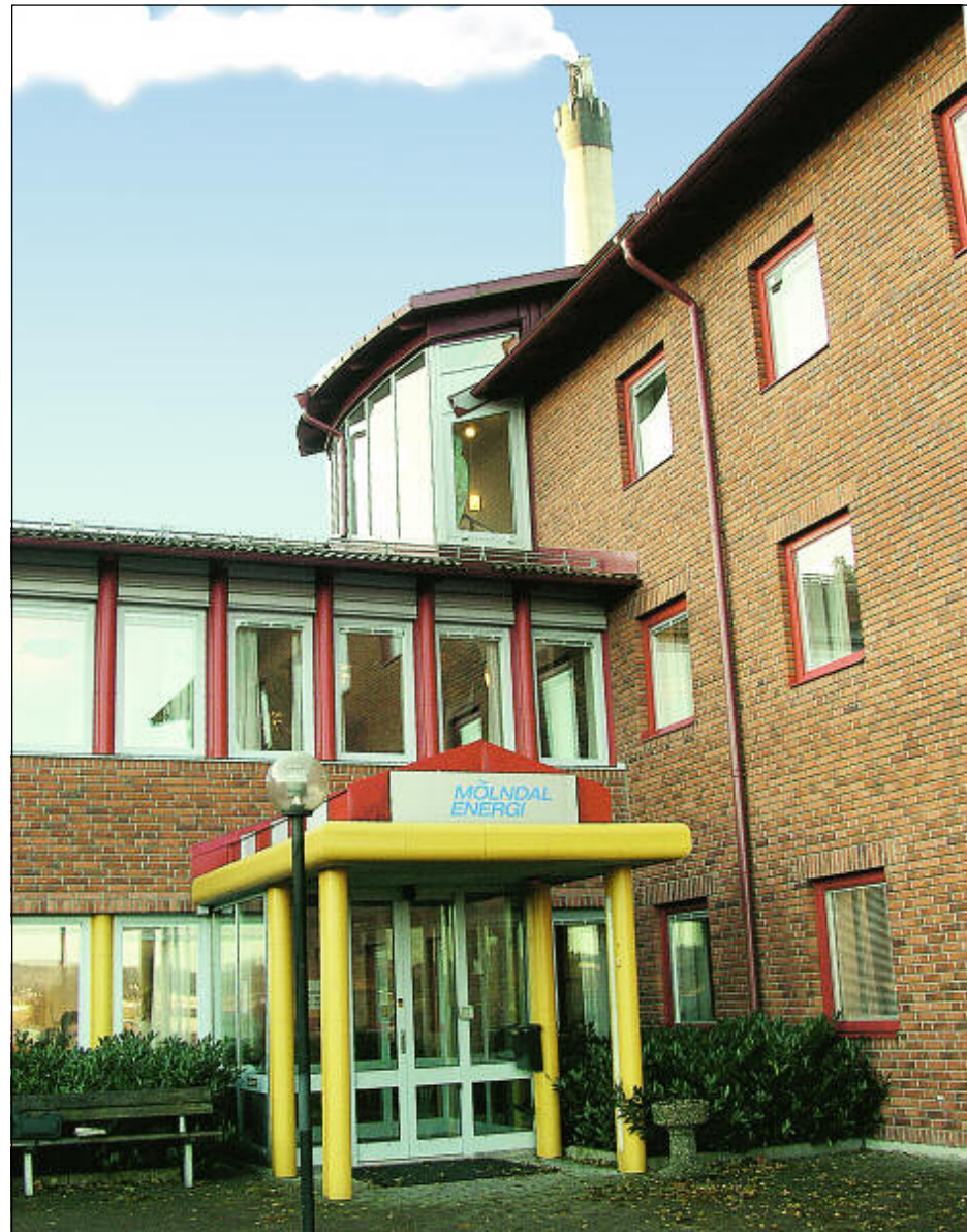
Riskullaverkets skorsten i full gång kalla dagar – en välkänd siluett mot himlen under vinterhalvåret. En utbyggnad av Riskullaverket säkerställer värmeleveranser till Mölndals invånare och företag långt in i framtiden.
